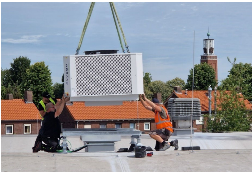
Installatie nieuwe units bovenop het dak
